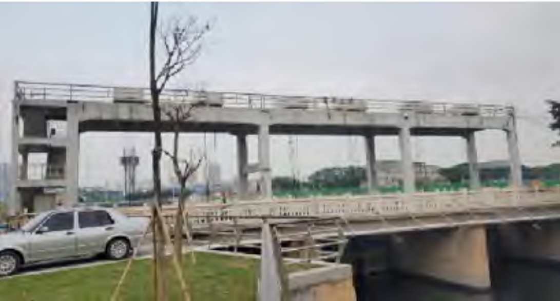
岗头水闸现状
